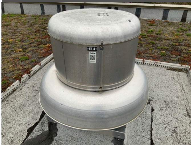
25 - ROOF TOP EXHAUST FAN
